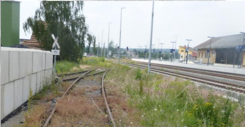
Anschlussbahn Hartberg; Foto: Mayer
