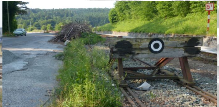
Verladebahnhof Rohrbach-Vorau; Foto: Mayer
